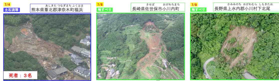
図 5.2: 令和 2 年 7 月豪雨による土砂災害例（令和 2 年 7 月豪雨による被害と対応 2 より図引用）
